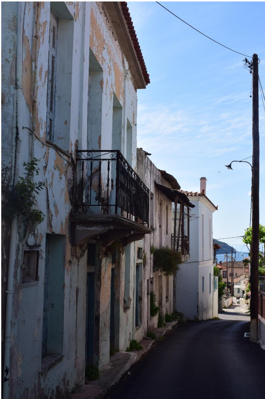
Εικ. 34. Δείγματα αρχιτεκτονικής στη Λίμνη Ευβοίας. Φωτογραφικό αρχείο ETAM Α.Ε.
