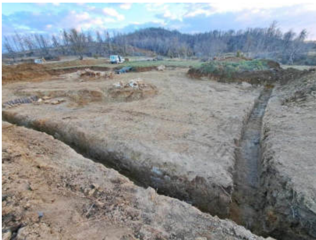
Απολιθωματοφόρα περιοχή 1. Κατασκευή δύο νέων καναλιών αποστράγγισης όμβριων υδάτων
